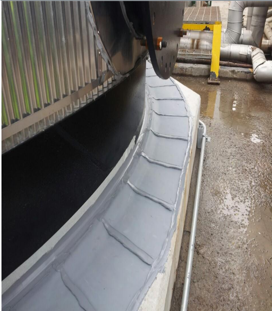
옥외 탱크(Tank) 시공 사진
