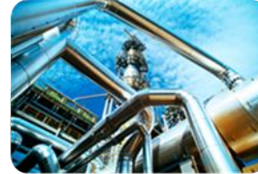
용도4. 염해성 플랜트 배관 보수 공사
