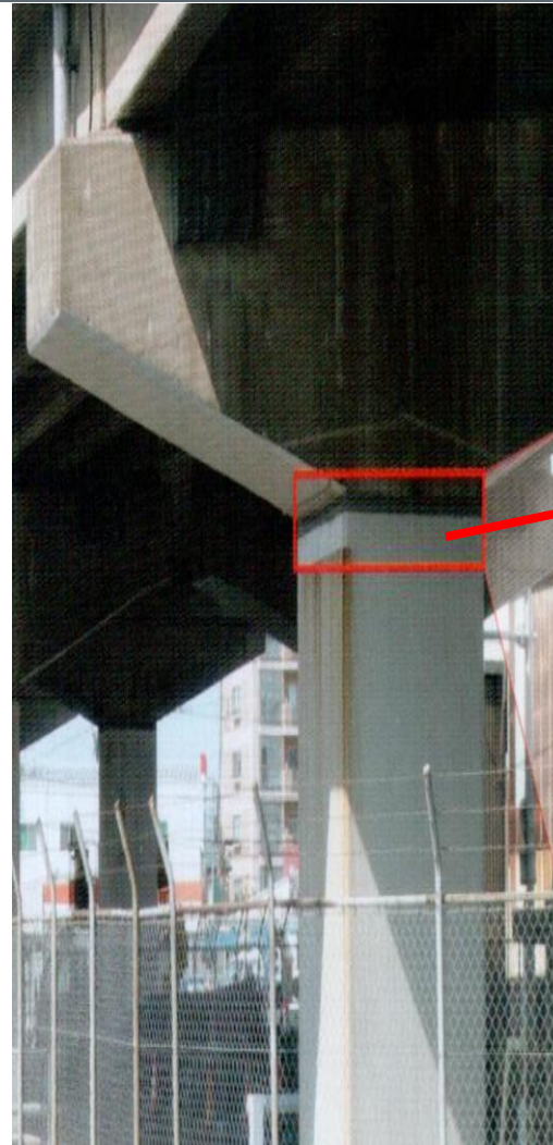
교량 시공 사진
